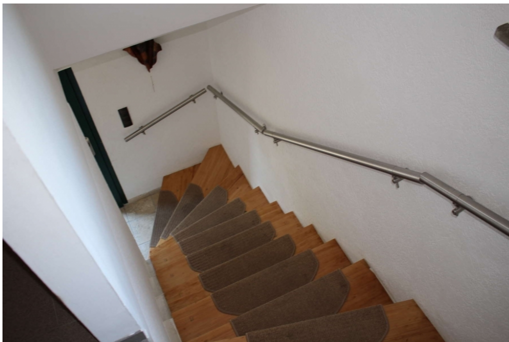
Treppe ins OG
